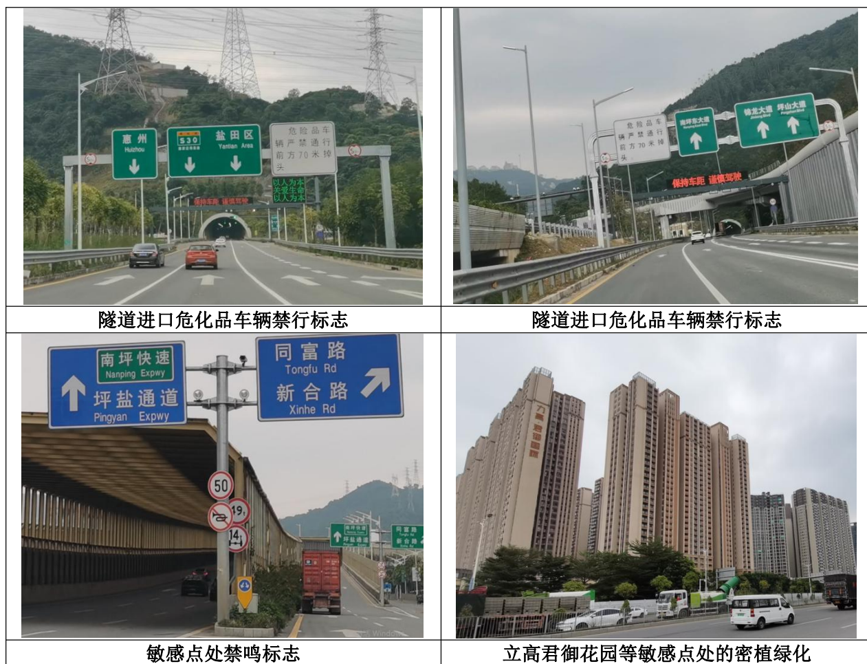
图3.2-2 道路沿线现状照片
