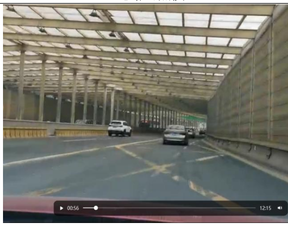
沿线全封闭声屏障
